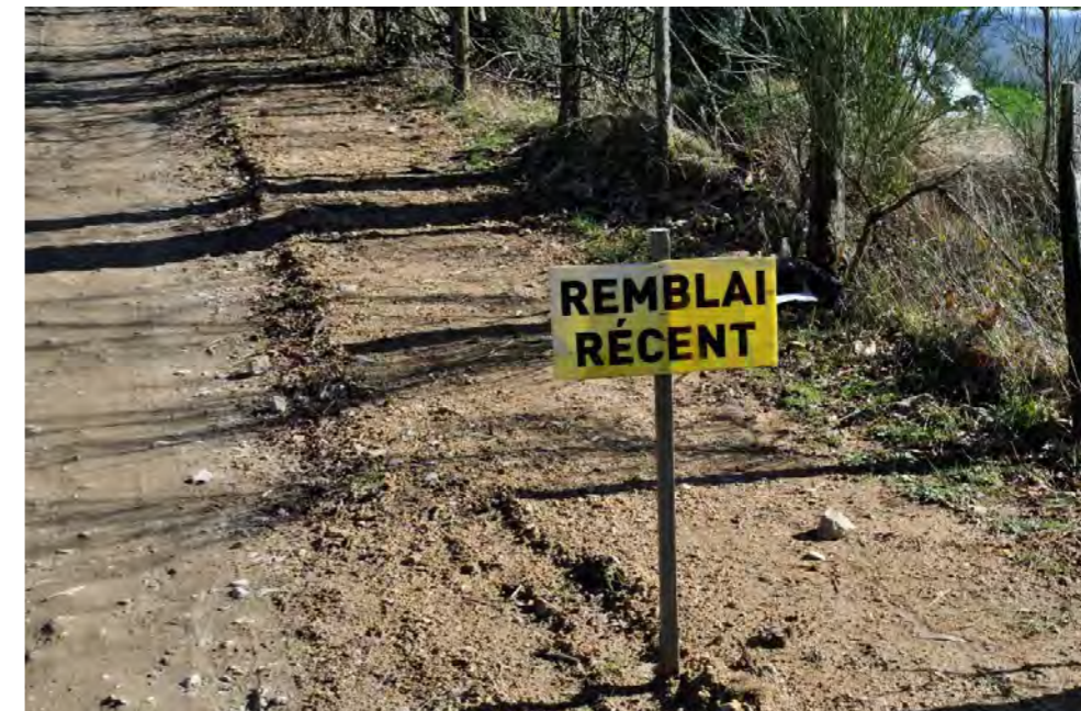
Photographie 49 : Exemple de remblai des tranchées électriques le long d'une piste
