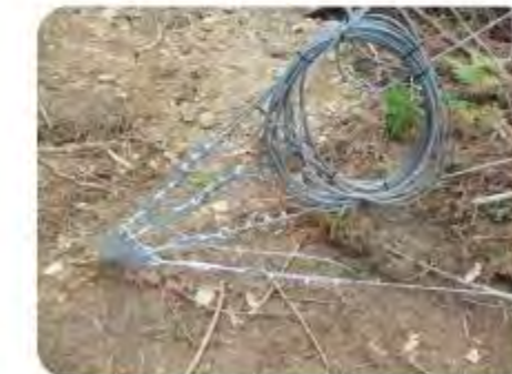
Ancrage des haubans au sol
