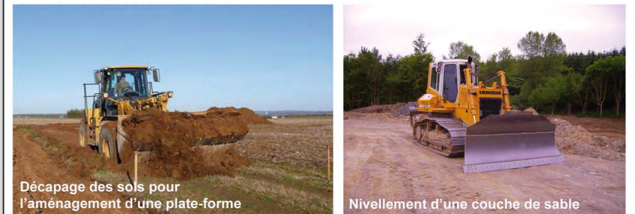
Photographie 43 : Exemples d'engins de travaux de VRD
