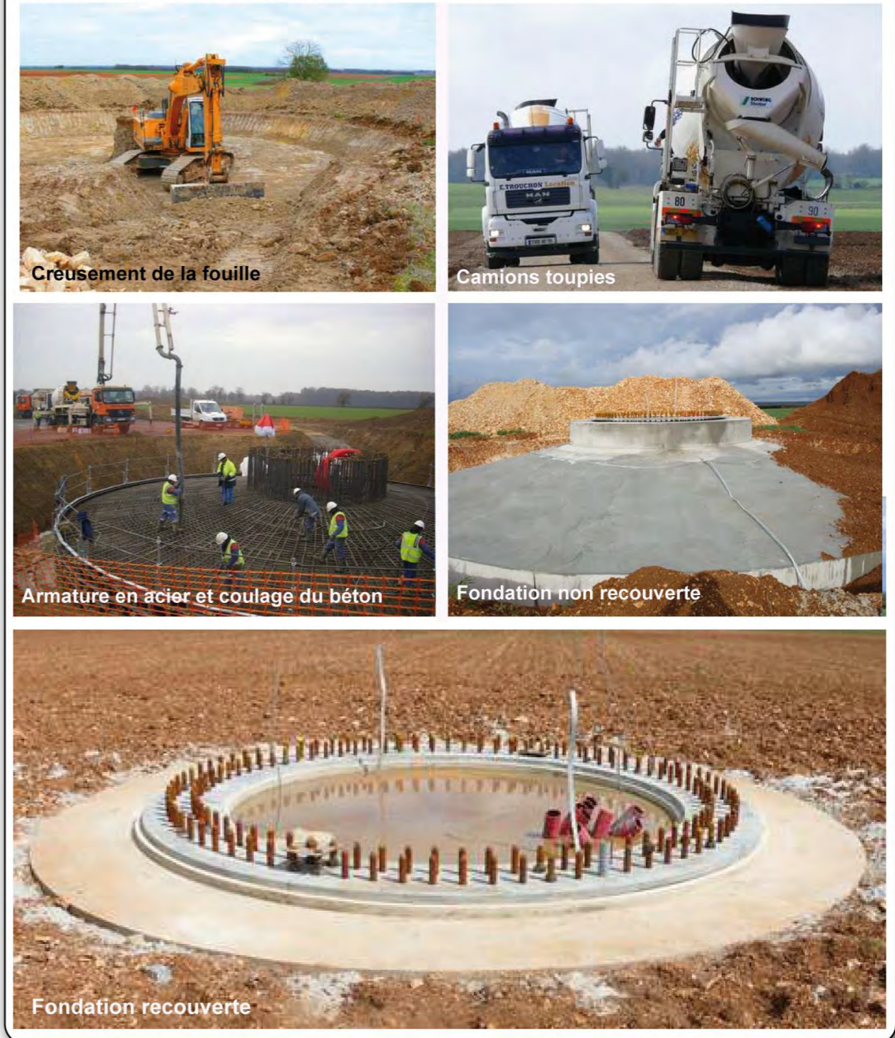
Photographie 44 : Etapes de réalisation d'une fondation d'éolienne
