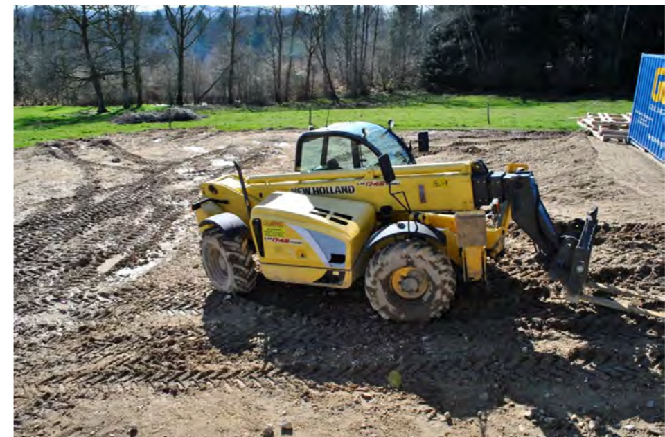
Photographie 47 : Exemple de tassement et d'ornières créés par les engins de chantier
