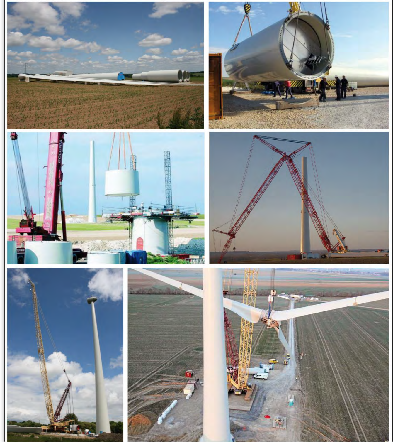
Montage d'une éolienne
