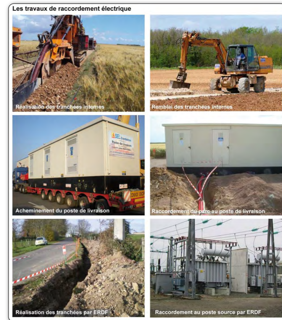
Photographie 45 : Travaux de raccordement électrique
