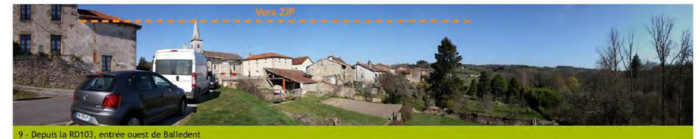
Photographie 28 : Vue du site depuis la RD103, entrée ouest de Balledent
