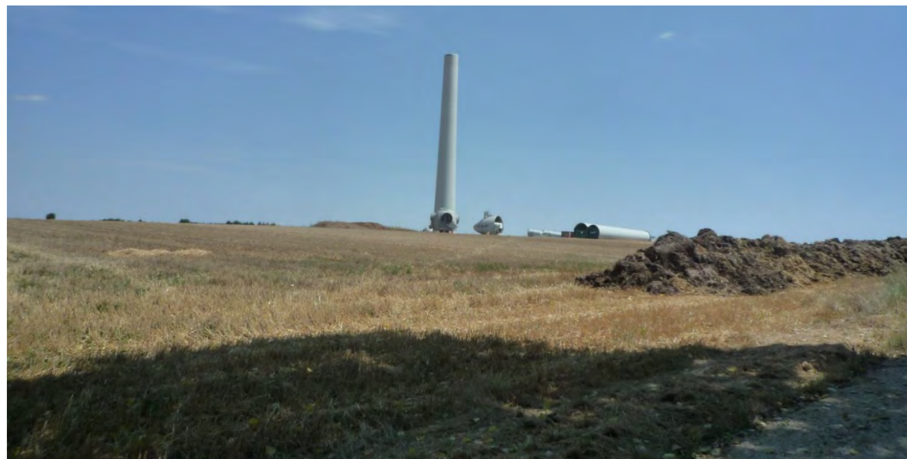
Photographie 48 : Exemple de stockage de terre durant un chantier éolien
